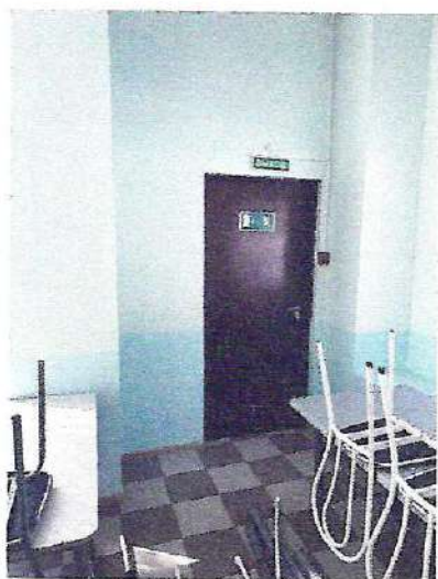
фото №4 «Пути эвакуации»
