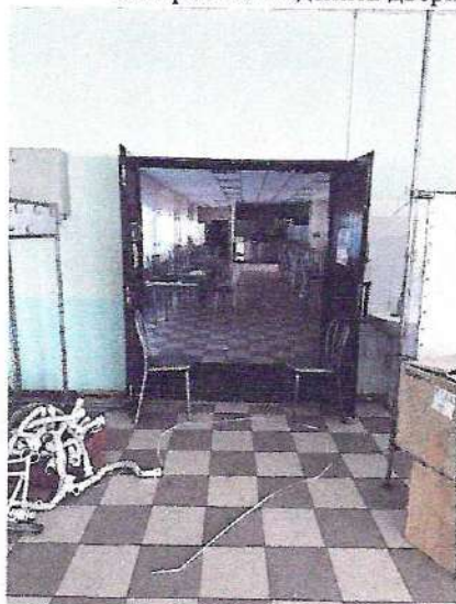
фото № 2 «Холл (вестибюль)»
