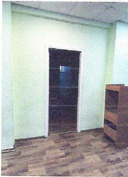
фото № 4 «Дверные проемы внутри здания»
