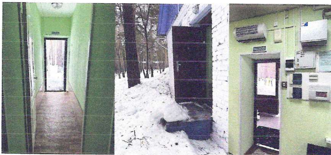
фото №5 «Пути эвакуации»
