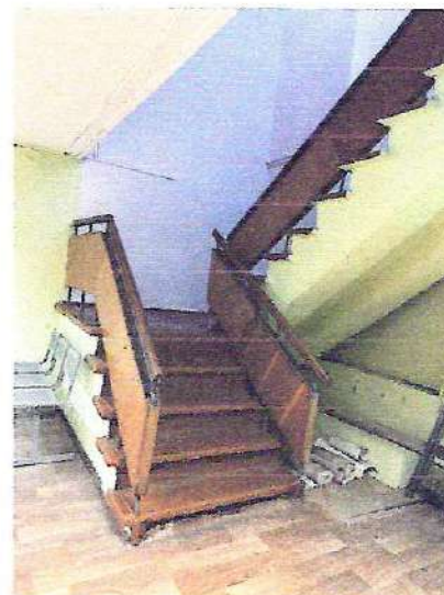
фото № 5 «Лестница (внутри здания)»
