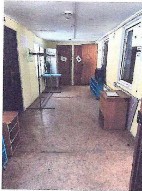
фото № 3 «Холл – вестибюль»
