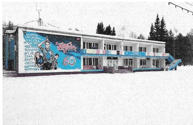
фото № 1 «Путь (пути) территория, прилегающая к зданию»
