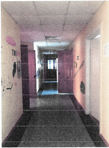
Фото № 5 «Коридор – 2 подъезд»
